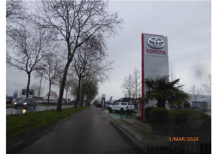
Enseigne scellée au sol
