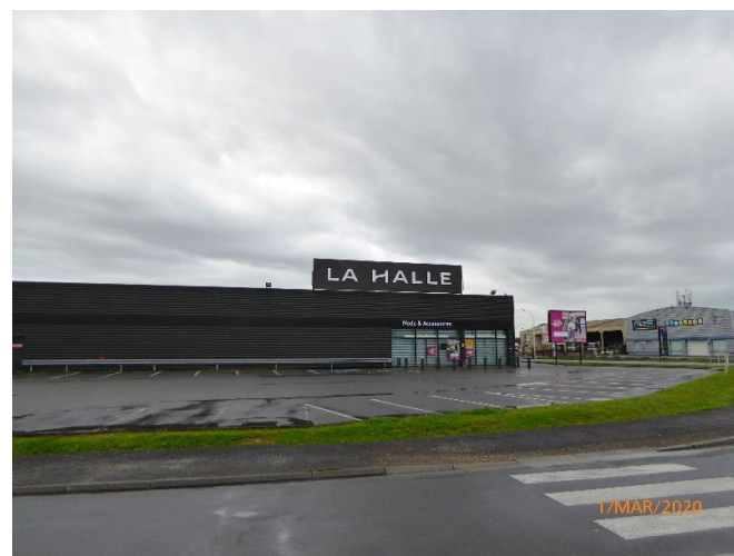
Enseigne en toiture non réalisée en lettres et signes découpés (artt.R.581-62 c.env.)
