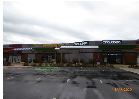
Enseignes parallèles au mur
