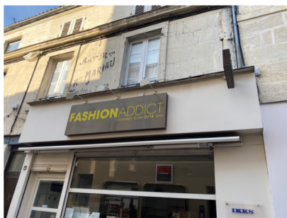
Les enseignes parallèles sous forme de caisson sont interdites en ZPI
