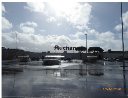
Enseigne en toiture
