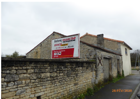
Dépasse les limites du mur (art.R.581-27 c.env.)
